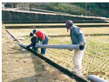
パイプの設置
