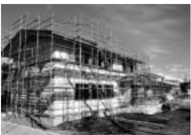
工事が進む(仮称)ワークプラザ
