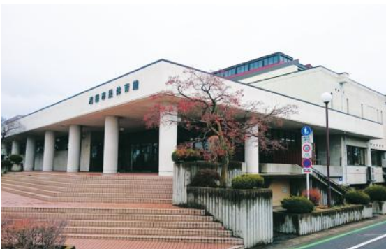
改修工事に着手した市民体育館
