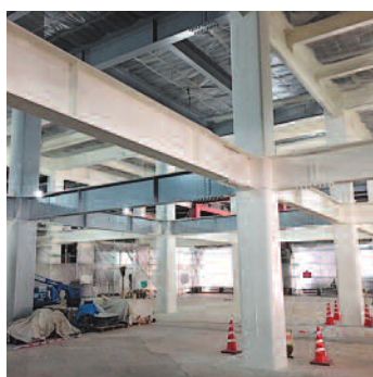
改修中のテラス沼田
