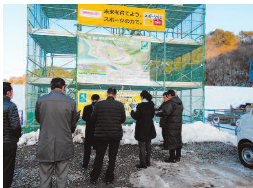
釜石市スタジアム建設現場を視察
