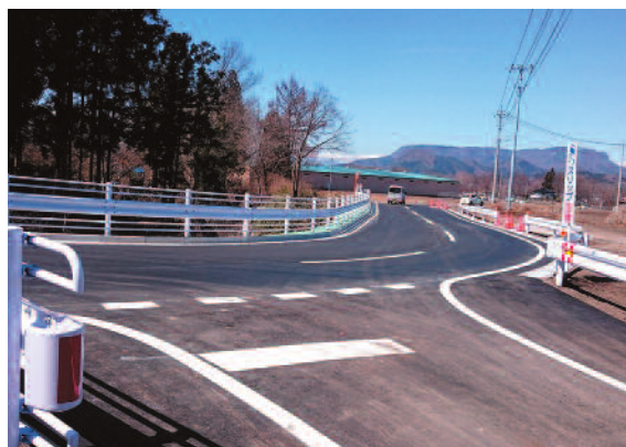
拡幅改良工事後の市道万部鍛冶屋2号線
