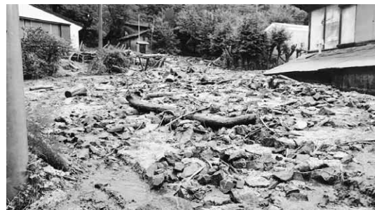
土石流災害(平成28年9月撮影) 利根町柿平
