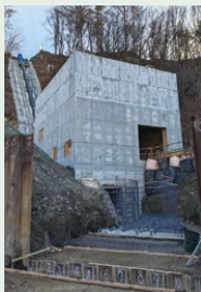
【図2】発電所建屋
