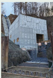
【図2】発電所建屋
