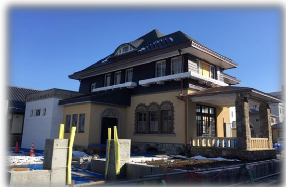
移築中の旧土岐邸洋館
