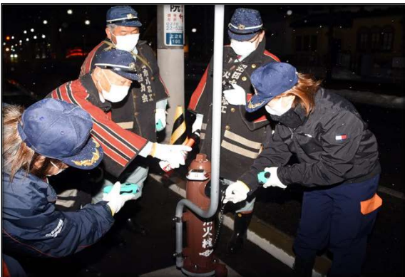
市内一円の消火栓などを点検しながらの警戒巡視を行いました。
