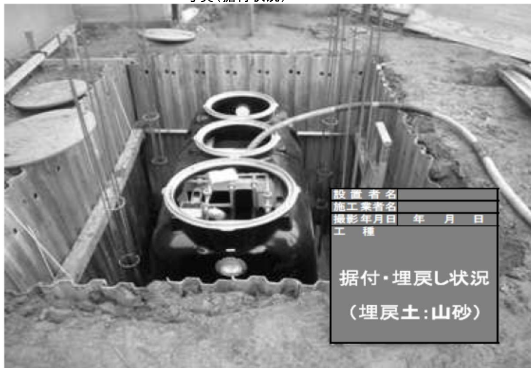
写真(据付状況)
