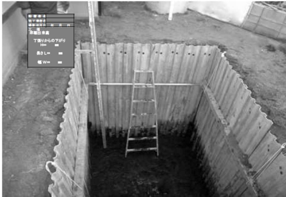
写真(床付け完了状況)
