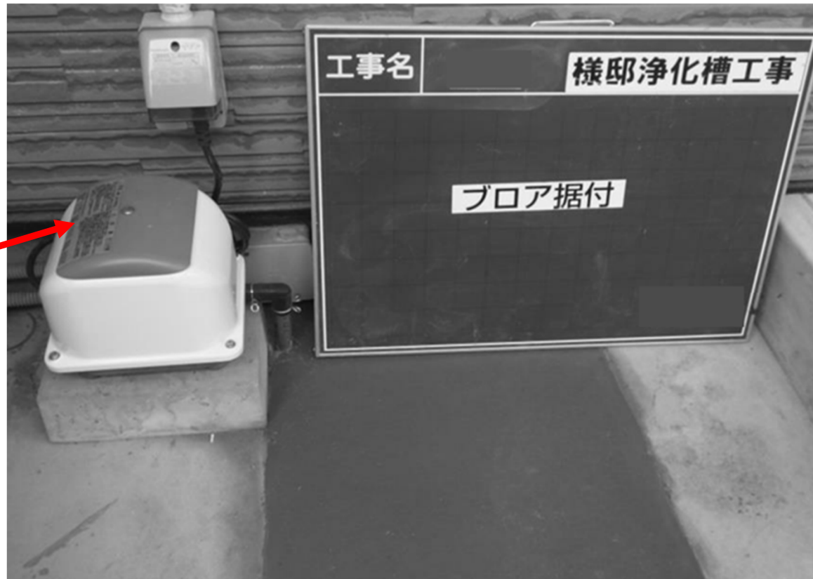
写真(設置状況)
