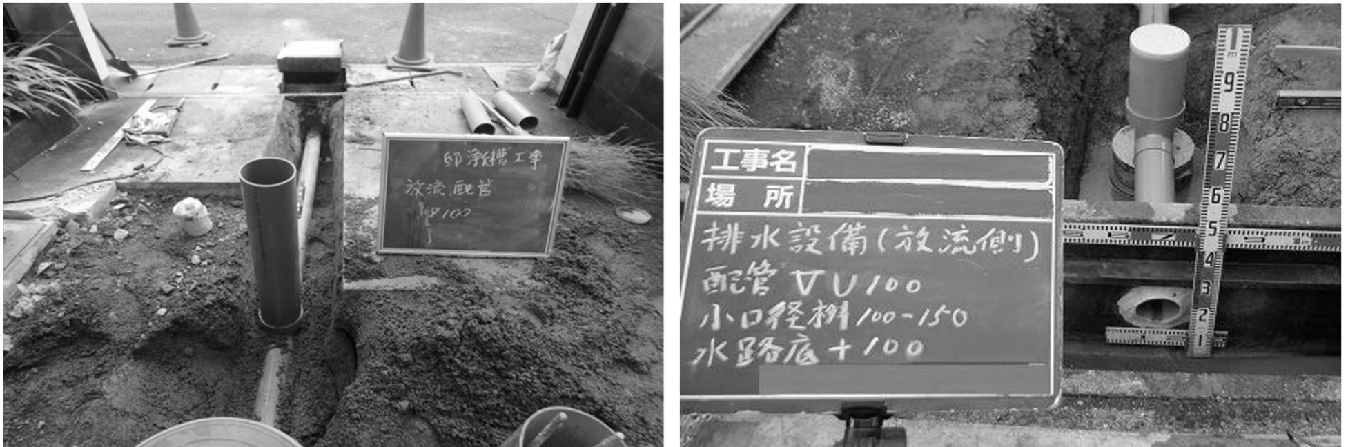
写真(放流先接続状況)
