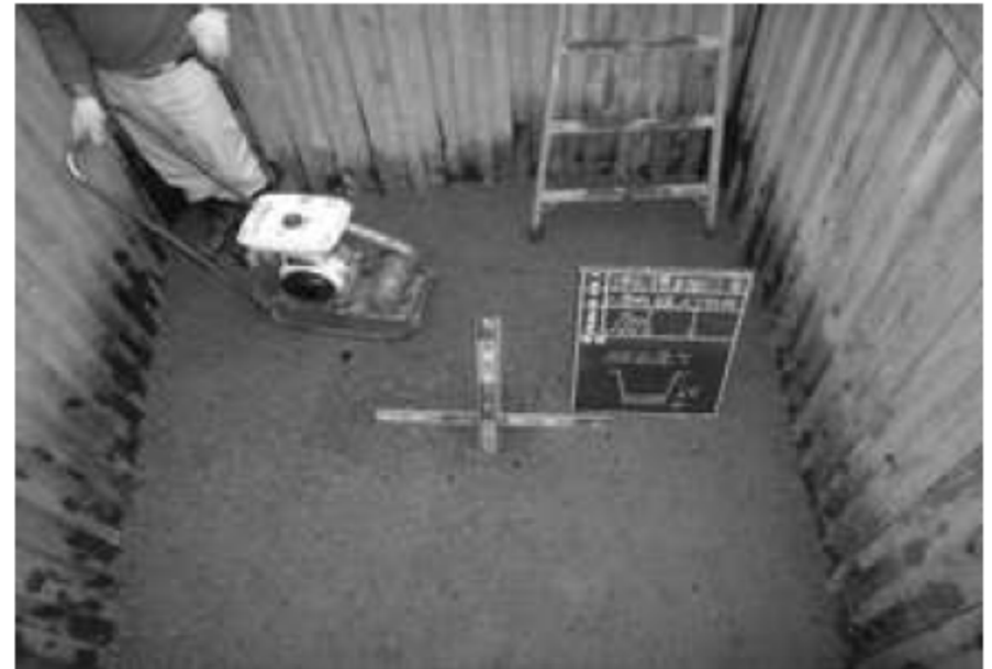
写真(基礎碎石仕上り状況 例2)
