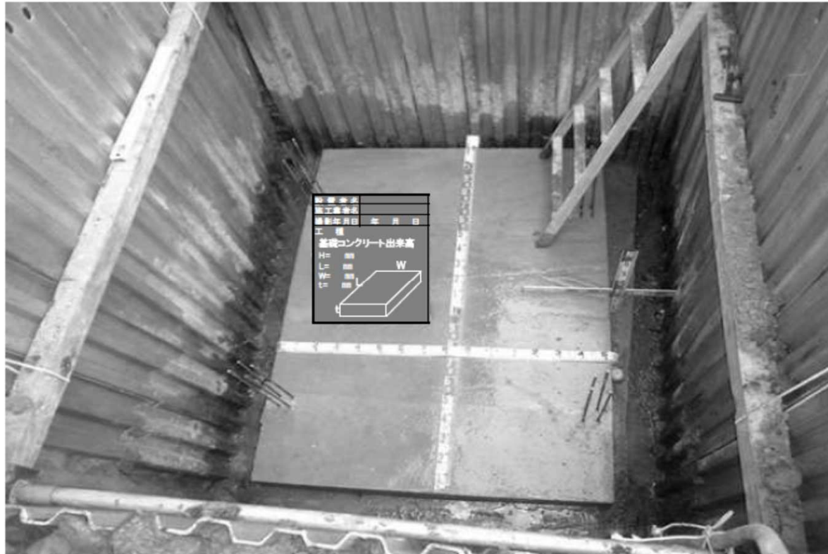
写真(基礎コンクリート仕上り状況)
