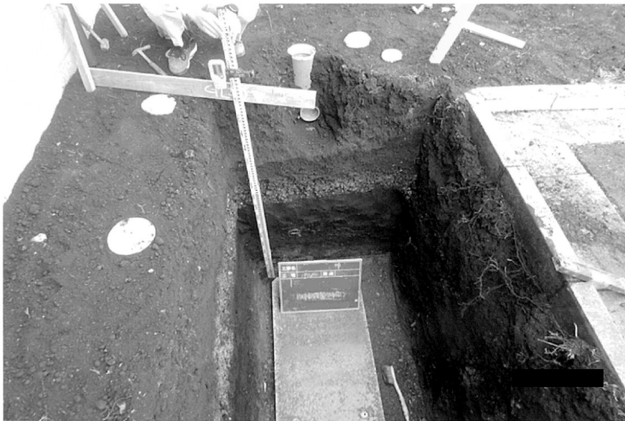
写真(PC板設置状況の写真)
