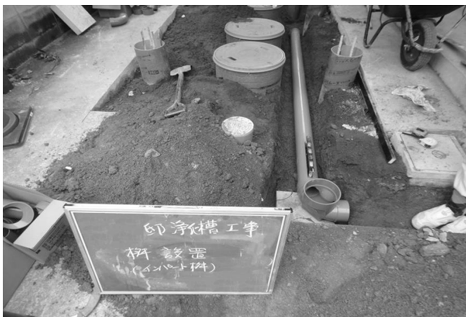
写真(宅内配管設置状況)
