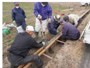
水路側壁の高上げ
