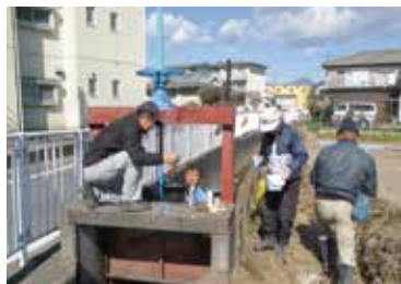
水門の塗装・注油
