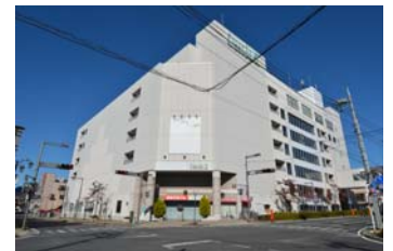
既存建物外観
