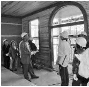
移設工事中の旧沼田貯蓄銀行
