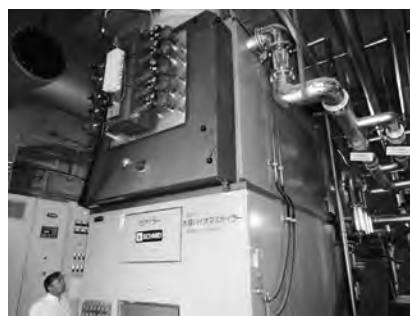
役場周辺地域熱供給システム施設及び木質バイオマスボイラー
