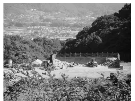
上川田最終処分場内廃プラ分別場
