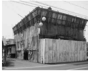
解体移転の進む1街区
