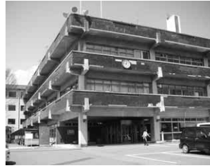
老朽化が進む市役所本庁舎
