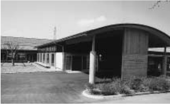
完成したふれあい福祉センター
