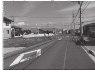
事業が進む3・3・1環状線(栄町工区)
