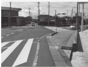
段差解消、視覚障害者誘導用ブロック設置でバリアフリー化
