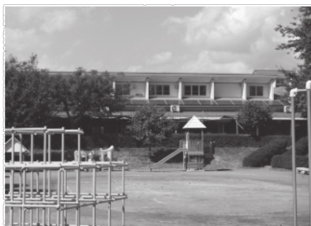
太陽光発電設備が設置された南保育園
