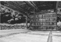
舞台上に走る追出し軌道
