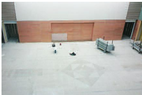
改修工事が進むテラス沼田5階の議会議場
