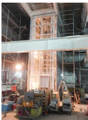
改修工事中のテラス沼田
