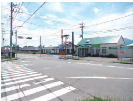
改修工事予定の市道国立病院下原線交差点
