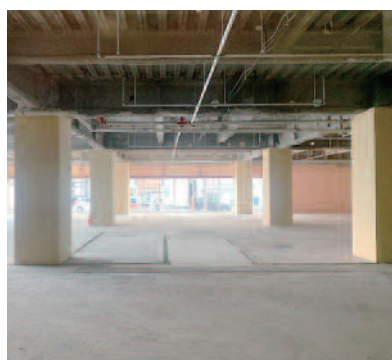
テラス沼田の1階テナント部分
