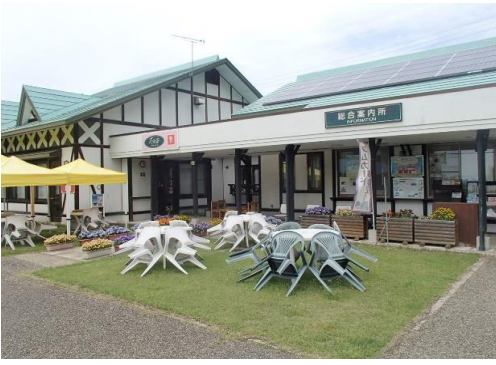
緑地等中央管理センター1
