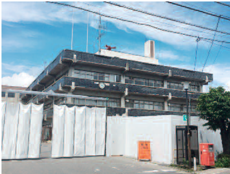
解体工事が始まった旧庁舎
