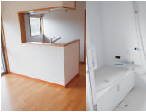
きれいに改修された東下原団地A棟（昨年度改修）
