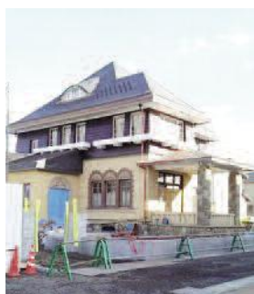
上之町にぎわいの核へ移築中の土岐邸洋館
