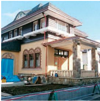
移築中の旧土岐邸洋館
