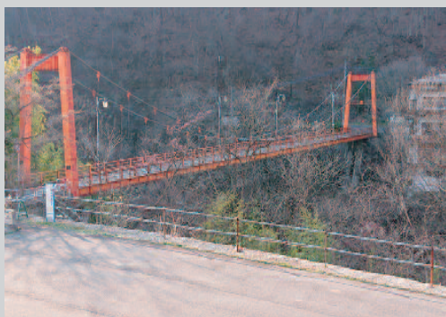
工事予定の内楽橋(利根町老神地区)
