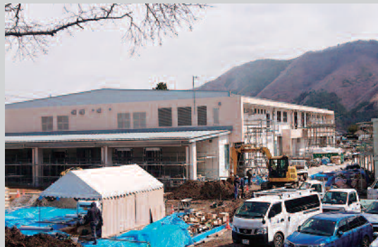
工事中の新学校給食センター
