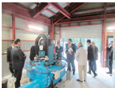
石徹白番場清流発電所を視察
