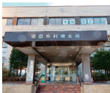
除却対象となっている利根支所
