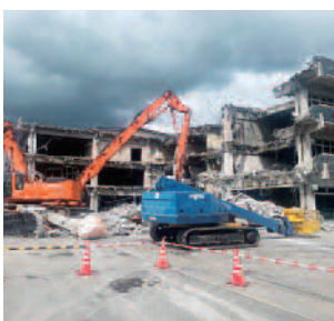
解体中の旧市役所
