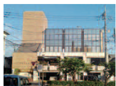
廃止・除却される中央公民館
