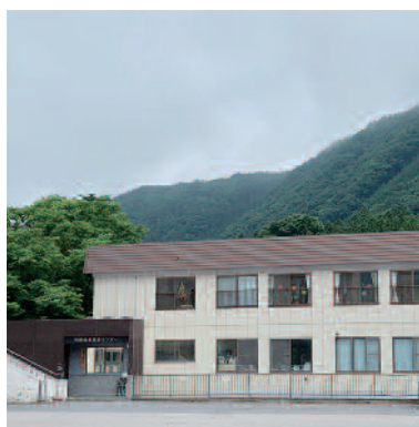
利根支所が仮移転する利根町若者定住センター
