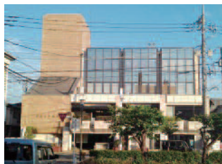
廃止・解体される沼田市の文化・芸術の殿堂として市民文化を育んできた中央公民館
