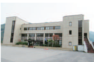
使用中止予定の利根支所庁舎
