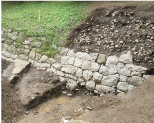
平成 27 年度調査で検出した本丸東面石垣 Stone wall of Numata Castle, 2015
