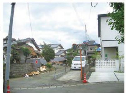
熊本地震 倒壊した家屋（左側）、無被害の家屋（右側）
