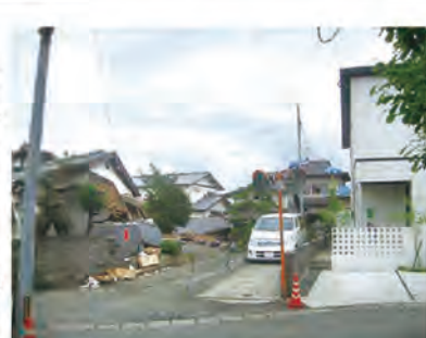
熊本地震 倒壊した家屋(左側)、無被害の家屋(右側)
