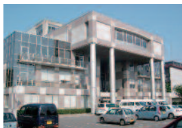
代替施設保健福祉センター
