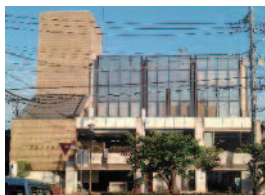
除却された中央公民館
