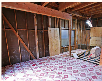
必要な柱を残してスペースを広げる
