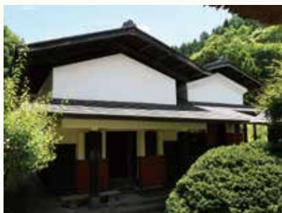
▲敷地内には4つの蔵があり、外壁はしっくいと土を混ぜて塗り固められている。農具や民具などを展示
