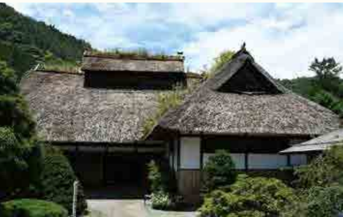
曲屋全景。母屋には蚕の飼育に使った越屋根が残っている
