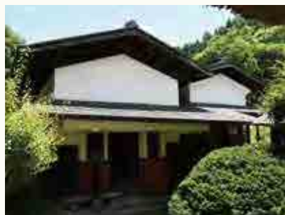
▲敷地内には4つの蔵があり、外壁はしっくいと土を混ぜて塗り固められている。農具や民具などを展示
