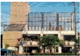
除却された中央公民館
