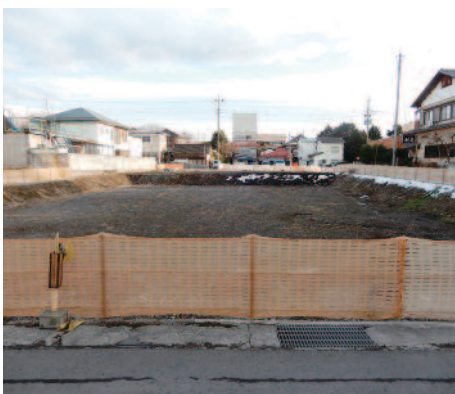
利活用が期待される中央公民館跡地
