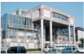
改修されたウエルプラザ
