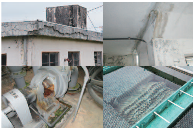
老朽化が進む浄水場
