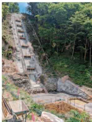
発電施設整備工事の様子
