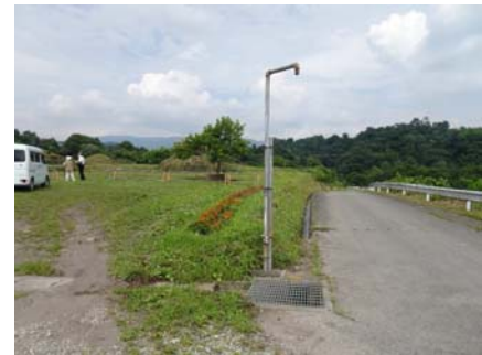
農業用給水塔
