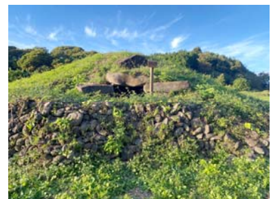
3号古墳 石室前面の改変（石積み）
