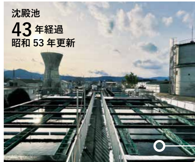
沈殿設備が変形し、供給能力が低下している
