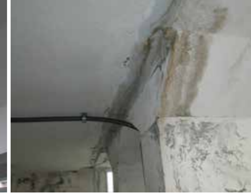
建物に亀裂が入り、雨漏りしている
