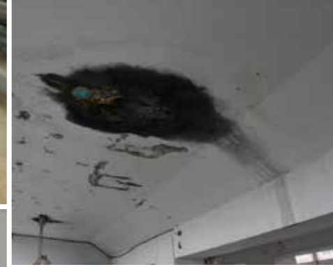
建物に亀裂が入り、雨漏りしている
