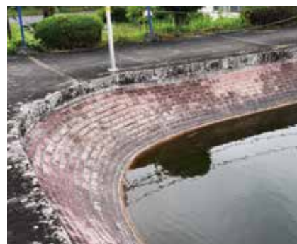
大正時代のレンガ造り（非常用貯水池）
