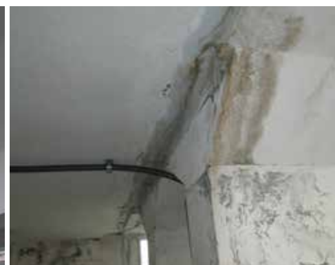
建物に亀裂が入り、雨漏りしている
