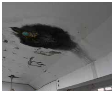
建物に亀裂が入り、雨漏りしている
