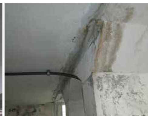
建物に亀裂が入り、雨漏りしている
