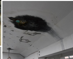
建物に亀裂が入り、雨漏りしている
