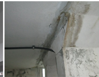
建物に亀裂が入り、雨漏りしている
