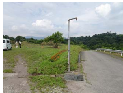
農業用給水塔
