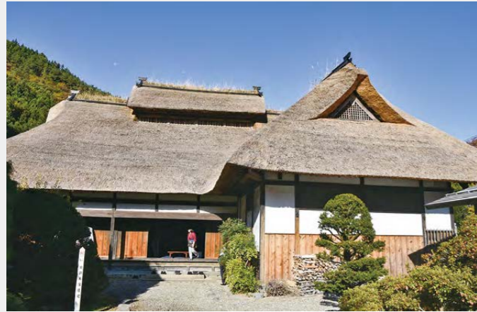
11/3 南郷の曲屋かやぶき屋根のふき替え完了 南郷の曲屋（利根町日影南郷） ふき替え完了を祝い、リニューアルオープン記念式典を行いました。昨夏から1年かけてふき替え、今年7月に公開と体験行事を再開しています。
