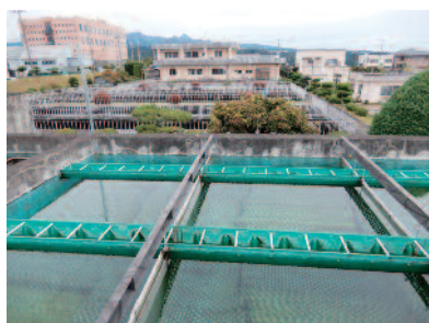
沼田市浄水場
