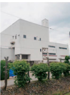
沼田市外二箇村清掃施設組合 清掃工場
