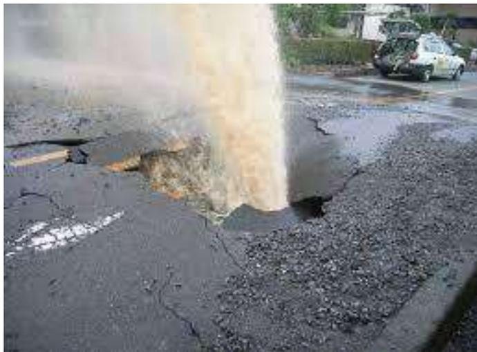
老朽化した水道管を放置すると大きな漏水事故につながりやすくなります。
