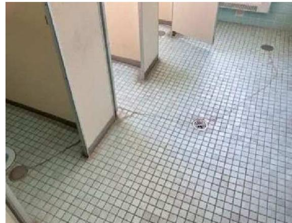
内壁のモルタル仕上げ材、トイレの床タイルにひび割れが発生しています。
