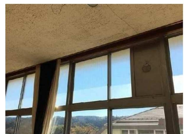
屋上防水の劣化が進むと、雨漏りが発生します。雨漏りは、カビの発生、電気設備の漏電、天井材の剥落を引き起こすだけでなく、屋根・床・柱・梁・壁などの構造体の劣化を急激に進めてしまいます。構造体は、他の部分と異なり、一部だけ取り替えることは困難であるため、構造体の劣化は建物の寿命を縮めてしまうこととなります。
