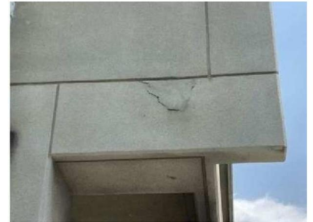
外壁の劣化が進みひび割れが生じると、外壁や柱などの構造体に雨が入り込んでしまいます。その結果、コンクリート内部の鉄筋がさび始め、そのさびが進行するとさびの膨張によりコンクリートやモルタルを破壊する「爆裂」現象を引き起こします。爆裂はコンクリートやモルタル片を落下させることもあり危険です。
