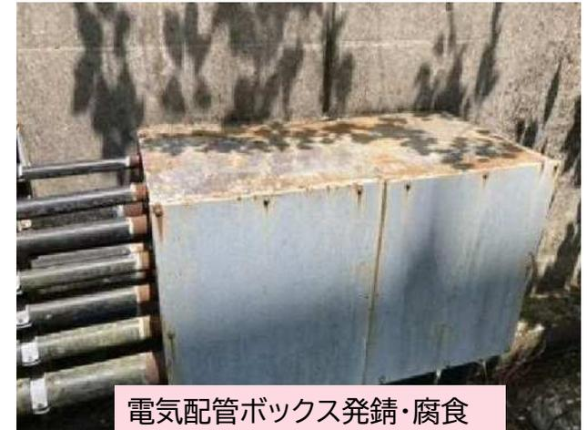
電気配管ボックス発錆・腐食
