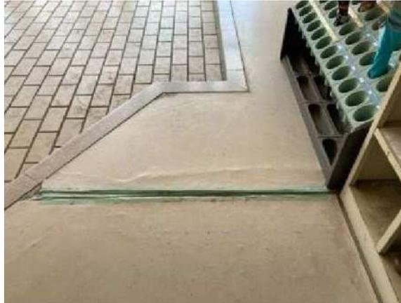
床材の剥がれ、シートの劣化によるはがれ、浮きが発生するなど、床材の劣化が全体的に進んでいます。部分的な修繕ではなく、全面改修が必要です。
