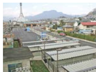
1 月・2 月／沼田駅前に駐輪場と駐車場が完成
