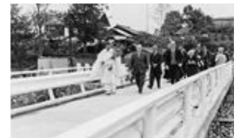
10月／四釜橋架け替え工事完成
