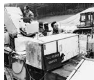
11月/最終処分場でフロンガスの抜き取り
