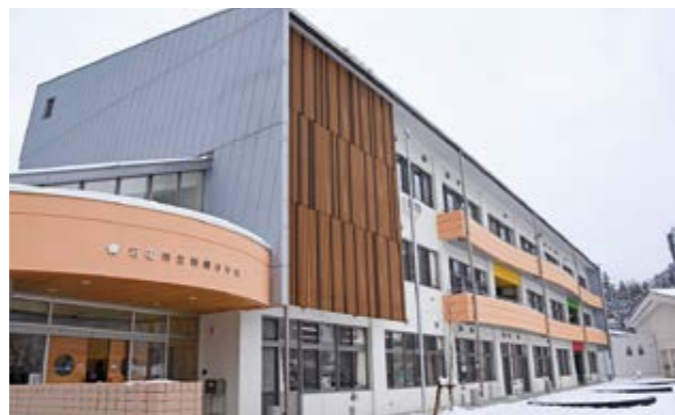
2月/利根小学校校舎完成
