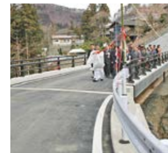
3月/新青木大橋が完成
