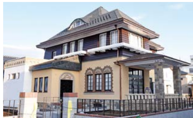
6月/旧土岐家住宅洋館を上之町へ移築し、開館
