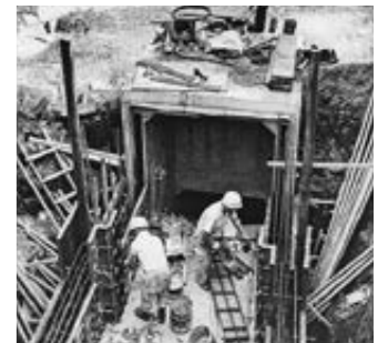
9月/上沼須町で都市下水路工事
