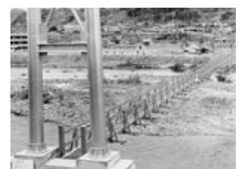
1月／沼田西中学校通学専用つり橋完成
