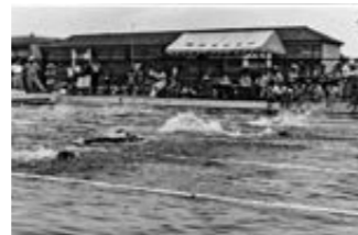
7月/沼田小学校にプール完成
