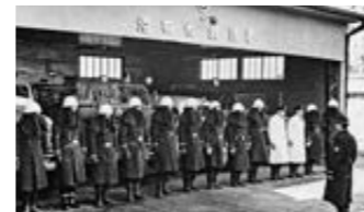
1月/市消防署。2月には火災予防条例を制定
